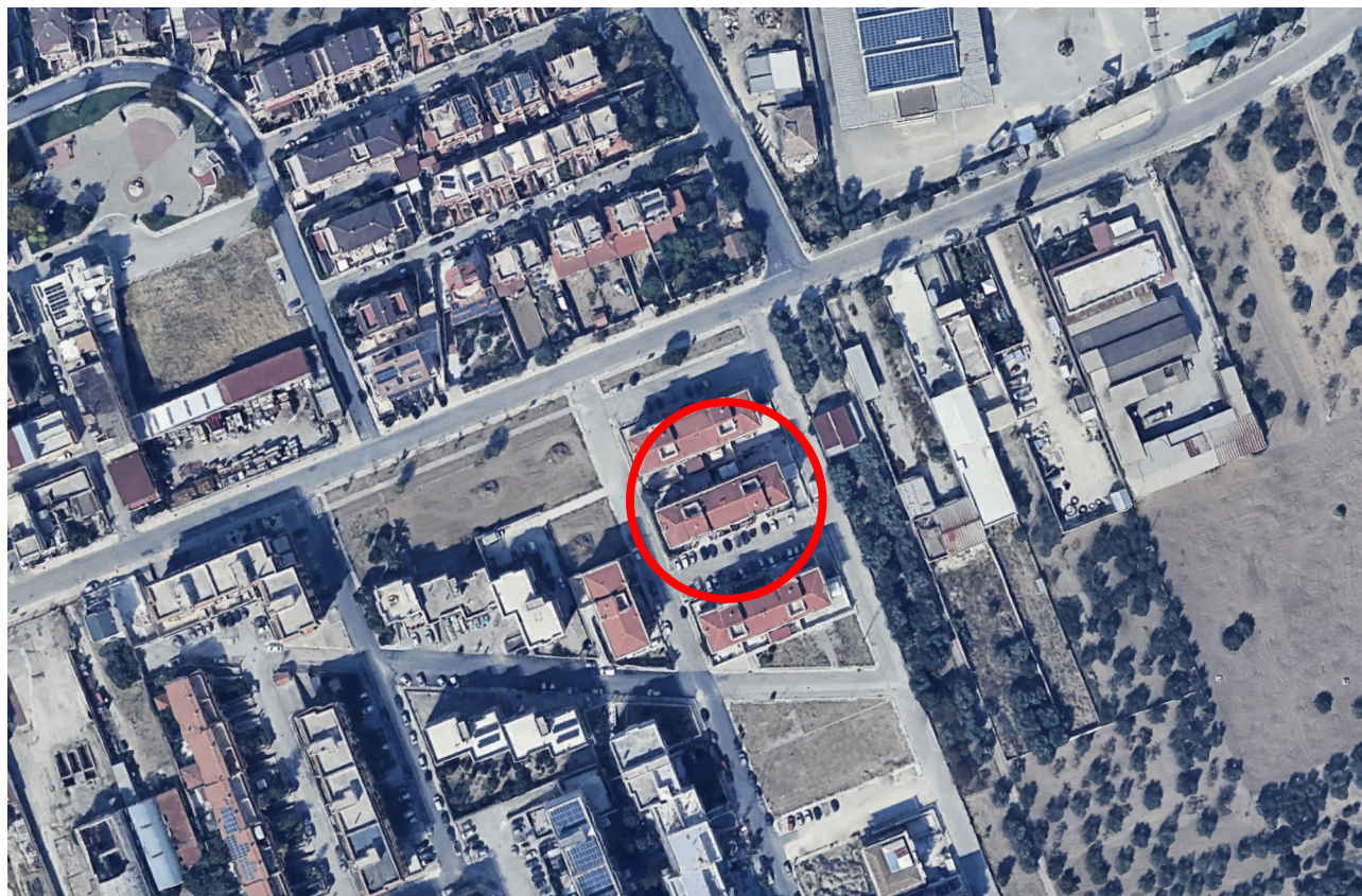
Figura n.2 (Inquadramento territoriale del fabbricato)
